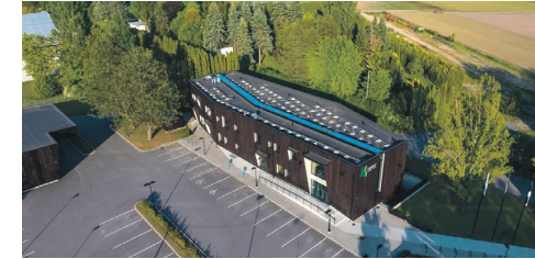
Tehnosüsteemide paigaldamine lamekatusele ja bituumenist hüdroisolatsioonikihi koormustaluvuse tagamine RMK peahoone unikaalsel puitarhitektuuriga ehitisel Tartus.
