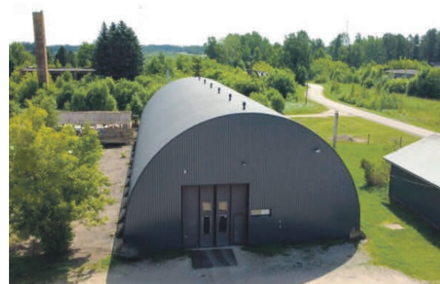
Täielikult korda tehtud ja soojustatud kaarhall on pärast renoveerimist valmis toimima energiatõhusa tootmis- või laohoonena.
