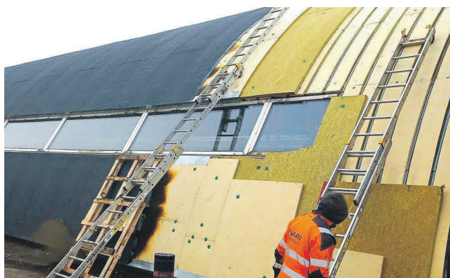
Kvaliteetne kaarhalli renoveerimine ja soojustamine väljastpoolt tagab hoonele täieliku ilmastikukindluse ning pika eluea.
