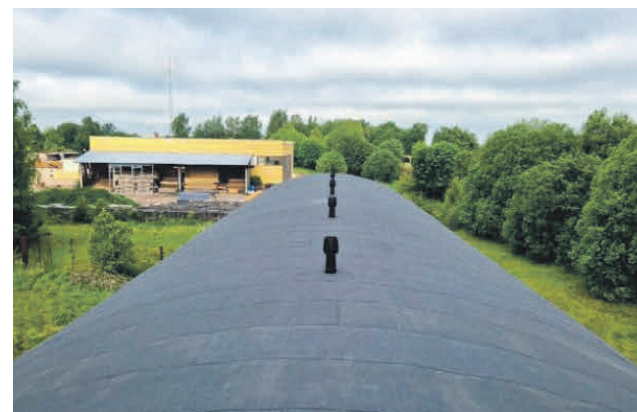
Terviklik kaarhalli renoveerimine hõlmab ka toimiva tuulutussüsteemi ehitust, mis juhib katusekonstruktsioonist jääkniskuse välja.
