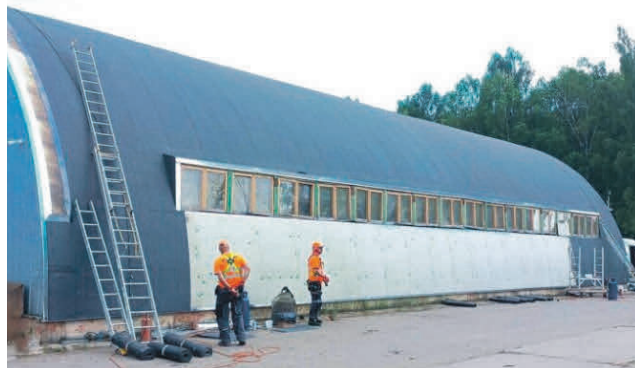
OÜ Evari Ehitus meistrid muudavad vana ja lekkiva kaarhalli renoveerimise käigus kaasaegseks äripinnaks.
