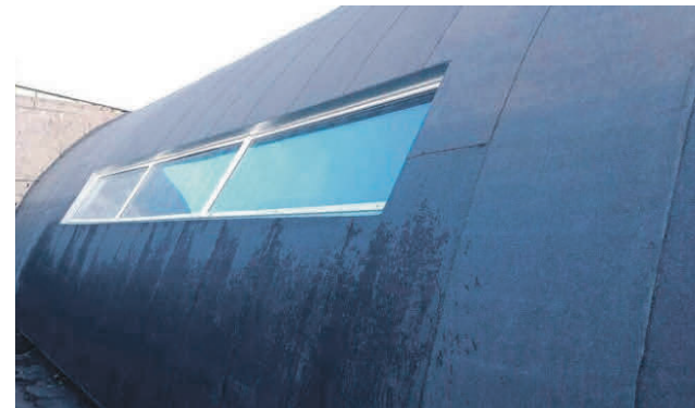
Kaarhalli renoveerimine välispidise soojustamise ja bituumenrullmaterjalist katusekatte abil annab vanale hoonele kaasaegse ilme ning täieliku veekindluse.
