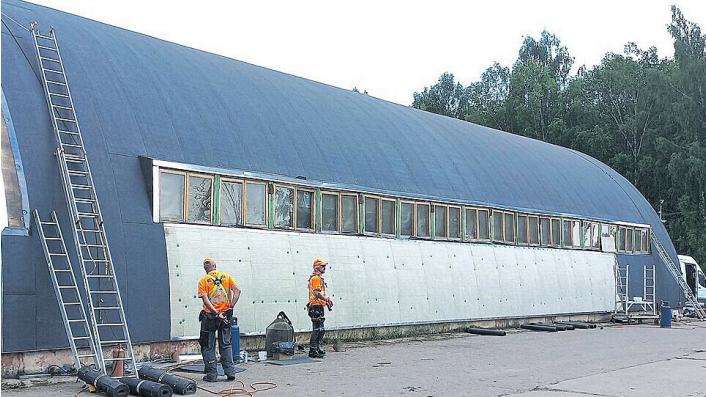
OÜ Evari Ehitus meistrid muudavad vana ja lekkiva kaarhalli renoveerimise käigus kaasaegseks äripinnaks.
