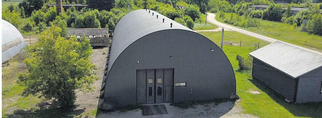
Täielikult korda tehtud ja soojustatud kaarhall on pärast renoveerimist valmis toimima energiaühenduse tootmis- või laohoonena.
