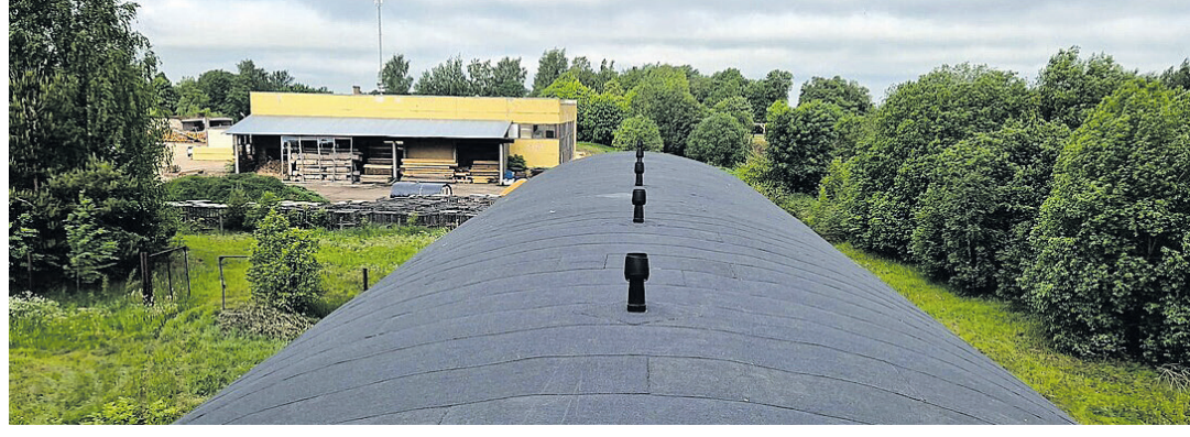
Terviklik kaarhalli renoveerimine hõlmab ka toimiva tuulutussüsteemi ehitust, mis juhhib katusekonstruktsioonist jääniiskuse välja.
