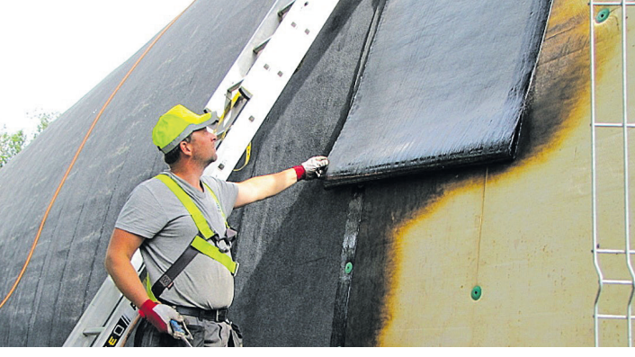
Katusespetsialist paigaldab kaarhalli soojustuskihile bituumenrullmaterjalist hüdroisolatsioonikihti, tagades rullide korrektse ülekatte ja mehaanilise kinnituse.
