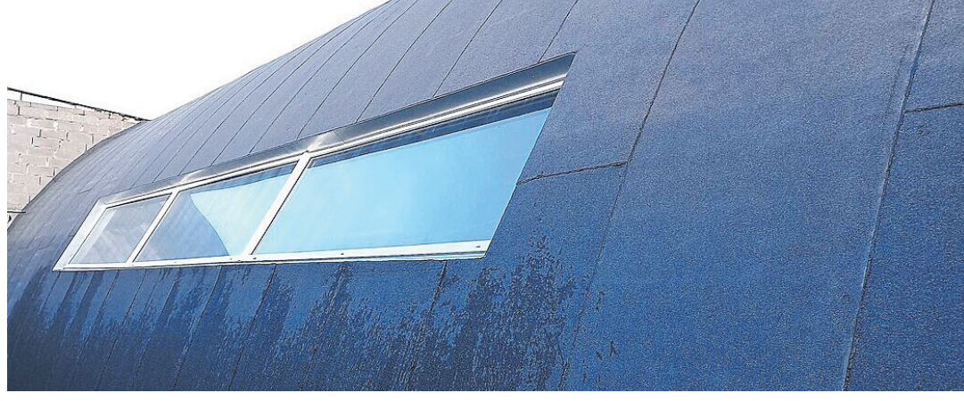
Kaarhalli renoveerimine välispidise soojustamise ja bituumenrullmaterjalist katusekatte abil annab vanale hoonele kaasaegse ilme ning täieliku veekindluse.
