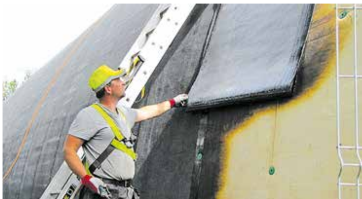
Katusepetsialist paigaldab kaarhalli soojustuskihile bituumenrullmaterjalist hüdroisolatsioonikihti, tagades rullide korrektse ülekatte ja mehaanilise kinnituse.
