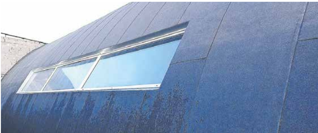
Kaarhalli renoveerimine välispidise soojustamise ja bituumenrullmaterjalist katusekatte abil annab vanale hoonele kaasaegse ilme ning täieliku veekindluse.
