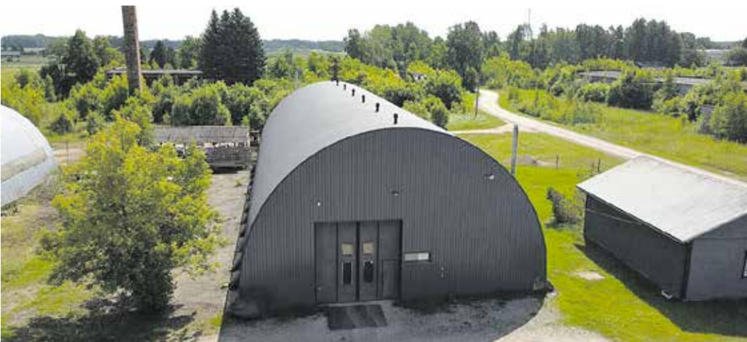
Täielikult korda tehtud ja soojustatud kaarhall on pärast renoveerimist valmis toimima energiatöhusa tootmis- või laohoonena.
